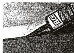
**3** Die Silikon-Dichtmasse wird nun gleichmäßig in die Fuge hineingedrückt
